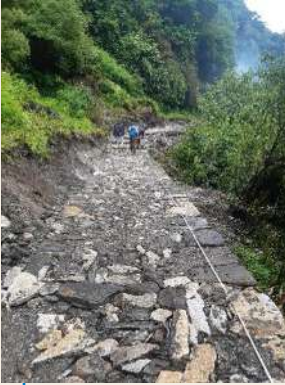
निर्माणाधीन कञ्चनजङ्घा पदमार्ग
