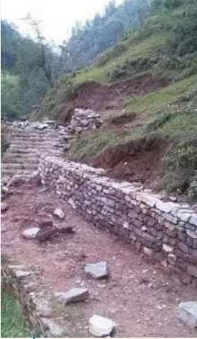
निर्माणाधीन यासाँ ट्रेल, रूकुम
